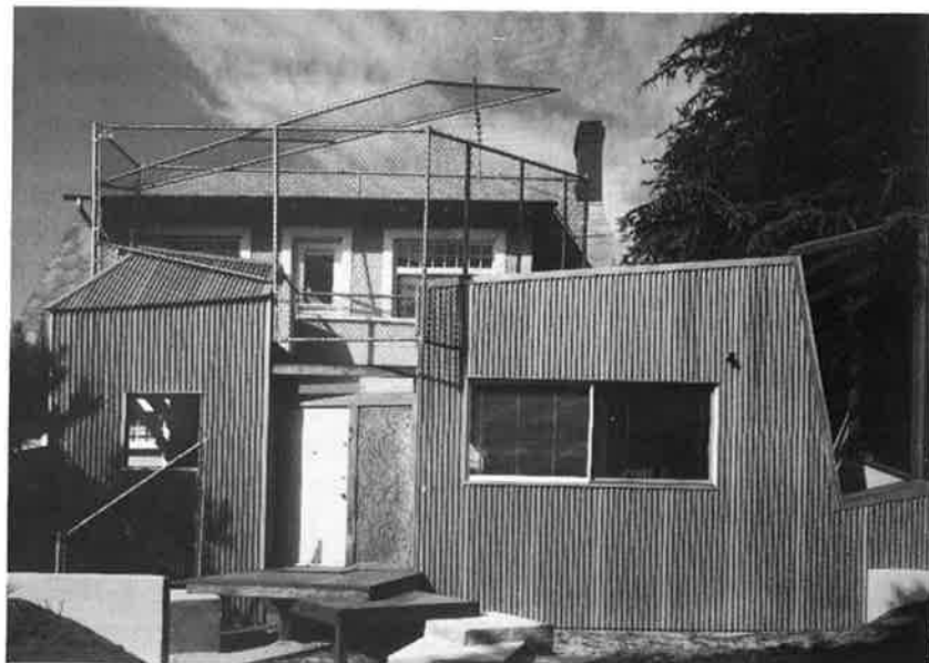
Entreezijde van Frank Gehry's huis te Santa Monica, Californië. Uit: Global Architecture, Houses 6, Tokyo 1979
