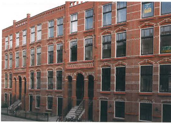
Scala, woningbouw Obrechtstraat in Den Haag Scala, housing Obrechtstraat in The Hague
