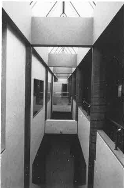
Links onder: Audiovisueel centrum Oita. De middenzone tussen de twee tongewelven met tussenschotten en lichtkap.
