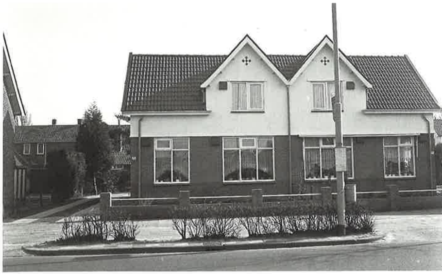
16 Renovatie woningen type HL. Vensters sterk gewijzigd; keramische pannen vervangen door betonpannen.
