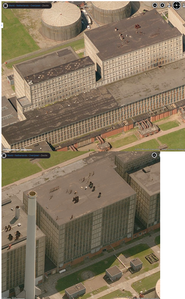
gevels gemaakt met slechts enkele typen prefab-panelen
