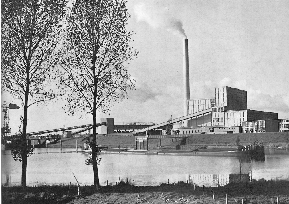
situatie 1955, gevel kolk zuid. kolenbunker domineert; grote reeks bijgebouwen en installaties. uiterst rechts het kantoor, links daarnaast pompegebouw. verder hier de transportbanden voor kolen + spoorweginfrastructuur.
